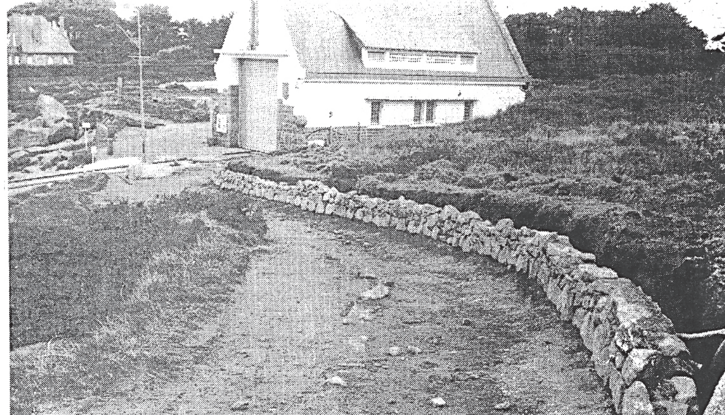
Près d'un kilomètre de murets en pierre sèche sera construit avant l'été entre la maison de toral et l'anse de Pors-Rolland.
